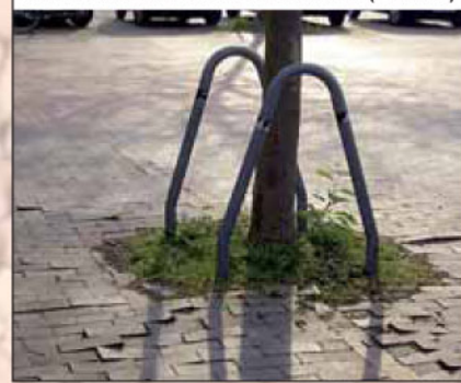
Oberflächennahes Wurzelwachstum (Pflaster)
