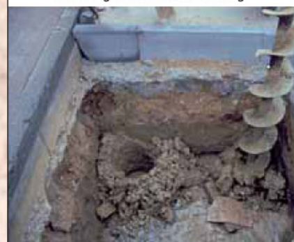
Bohrungen für Tiefenbelüftung
